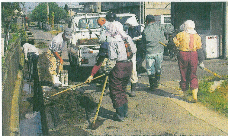
水路の泥上げ
